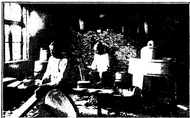
Kirbu küla Kopli talu puunõude-tööstus. Teoksil vanni valmistamine ja riistalaua tahumine.
