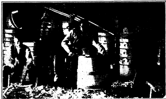
Maetsma küla Reiera talu puunõude-tööstus. Esiplaanil „jänni“ valmistamine — n. n. „ämmalõuaga“ viitsa pealeajamine.
