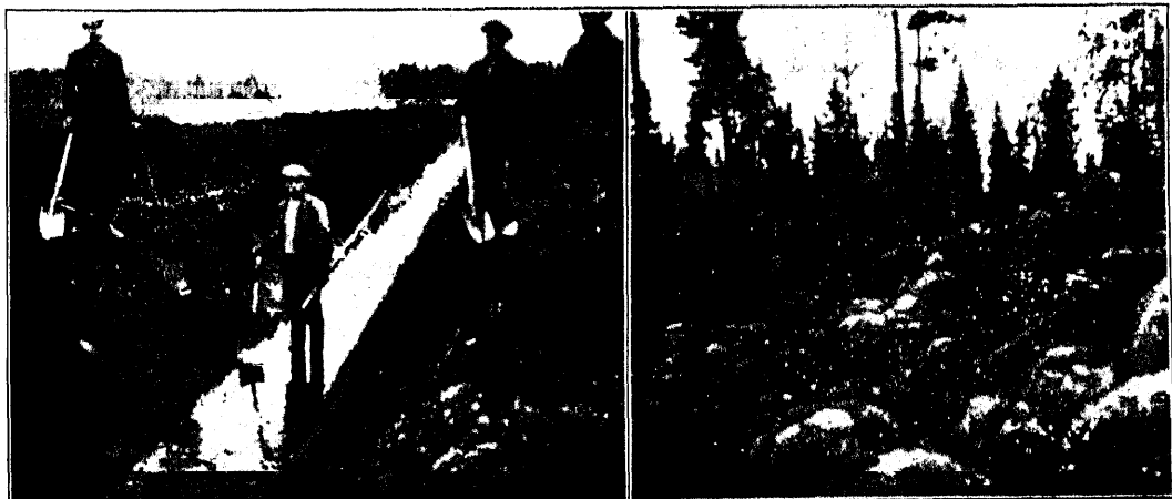
Magistraalkraav „Kotka“ läheduses asetseva Kymi valla soos. Pildil tööliste artell, samuti tööriistad, milledest aukudega porilabidas peaks meil võetama tarvitusele, mille otstarbekohasus selgus ka autori poolt tehtud katsel T. Ü. õppe- ja katsemetskonnas.
