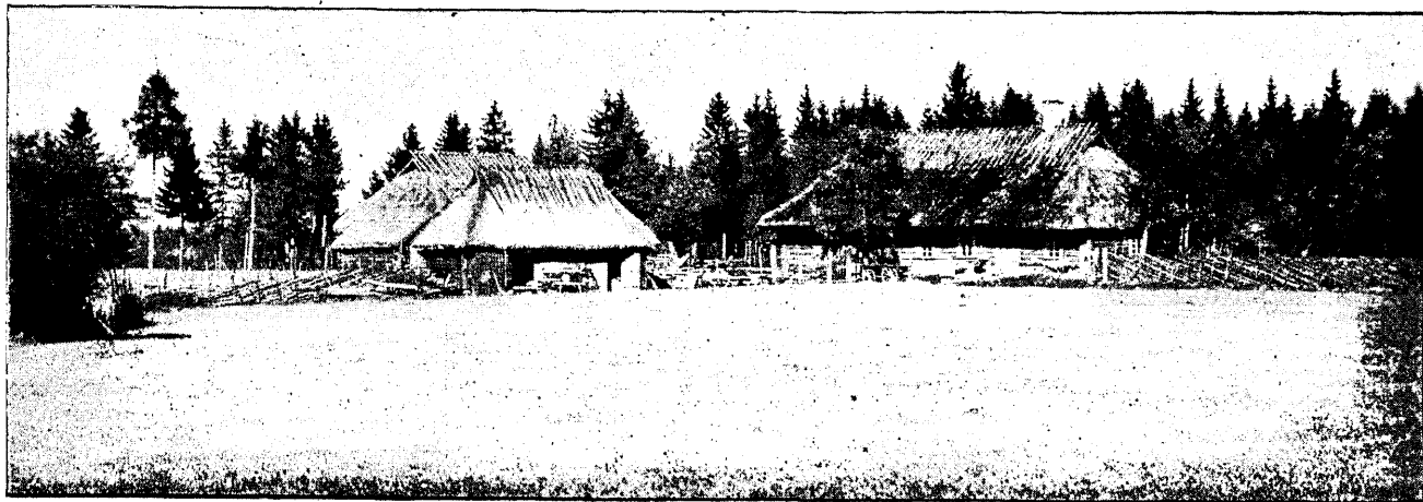
Üllaste riigirendi-talu Läänemaal
