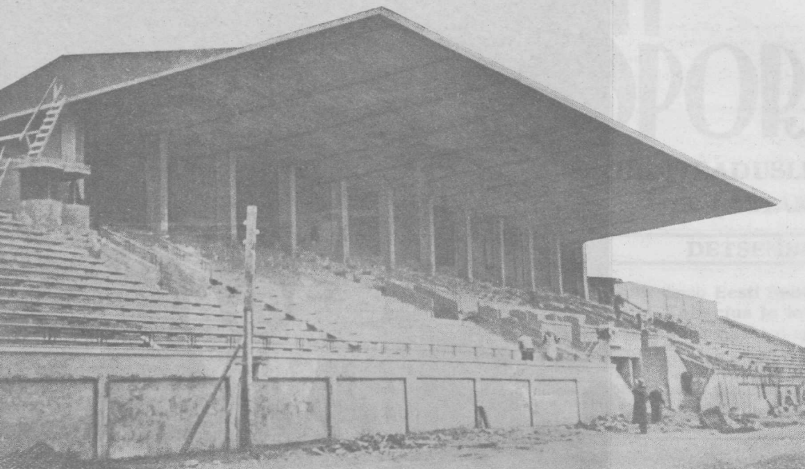
Tallinna uus staadioni tribüün pooleldi ehitamisel novembris. Nüüd on tribüün täiesti valmis
