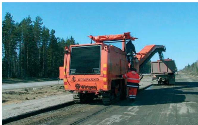
Vana asfalt freesiti.
