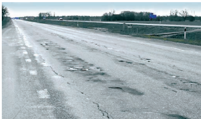
Mauno Napari foto vasaku sõidusuuna kulumud kattest
