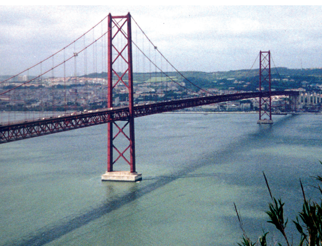
Ripsild Ponte 25 de Abril, mis on maailmas Kuldvärava ripsilla kõrval teine punasevärviline suurripsild (üle 1000 jm), kutsutud "Lissaboni Kuldvärava sillaks". Ülesvõtte 1990. aastast Lissabonist läbivoolava Tejo jõe lõunakaldalt. Põhjapüloon fotol paremal. Foto: Juhani Virola
