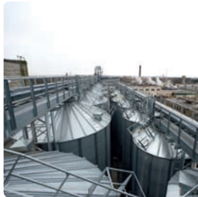
▣ VAADE PUNKERLAOLE ÜLEVALT: KOKKU MAHUB SIIA CA 4000 TONNI SÖÖTA.
