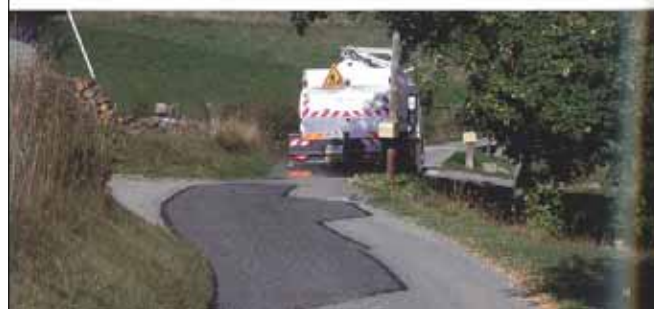
Pildil: SECMAIRi masin lokaalsete või erikujuliste kattedefektide pindamiseks
