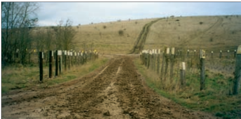
Tankiteede ristumine avalike teedega on tähistatud postiridadega. Väljaspool tähistatud ristmikku ei tohi tankid avalikke teid ületada. Ületuskohade alus on betoneeritud ning sinna koguneva pori eemaldab polügooni oma koristusteenistus.
