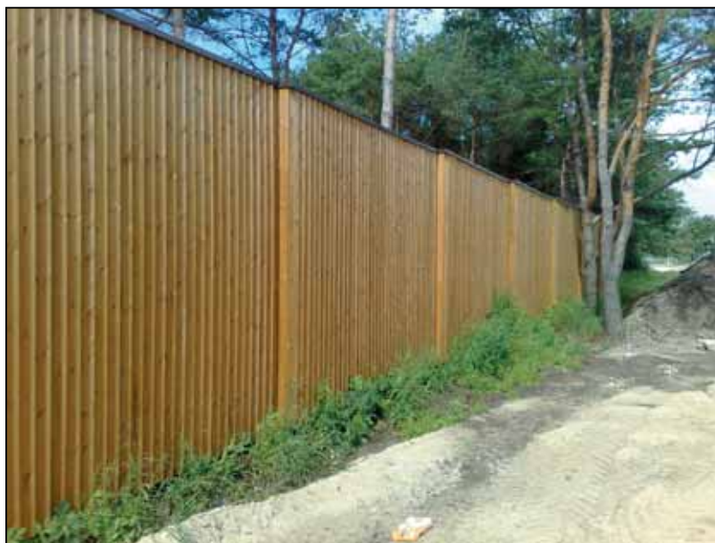
JOONIS 3: EESMÄRKI MITTETÄITEV MÜRATÕKE
