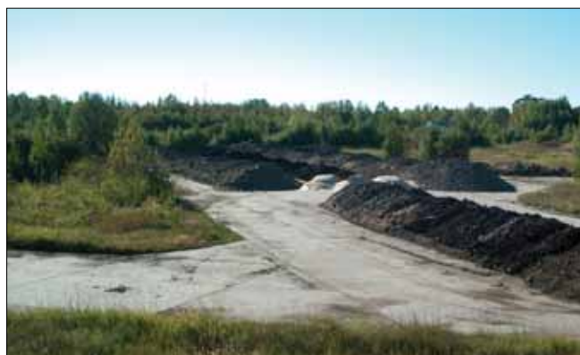
NAFTASAADUSTEGA SAASTUNUD PINNASE AUNAD HAAPSALU OHTLIKE JÄÄTMETE KOMPOSTIMISVÄLJAKUL
