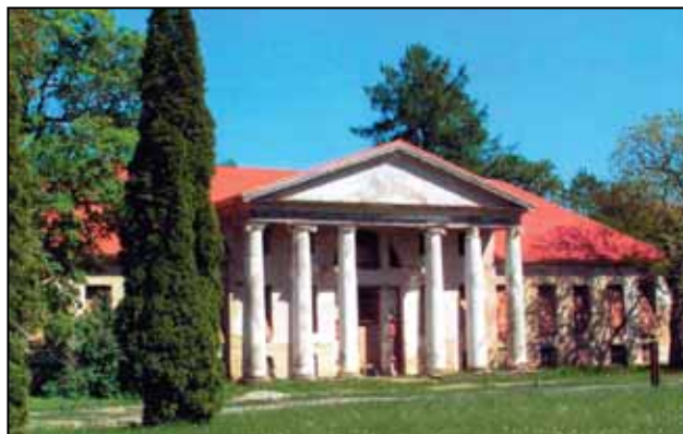
MÕISA PEAHOONE ESIFASSAAD PÄRAST UUE KATUSE VALMIMIST Alo Särg, 2007
