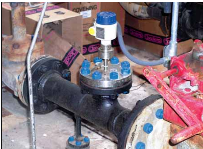
JOONIS 4. SmartCET-i ANDUR PROTSESSI PAIGALDATUNA
