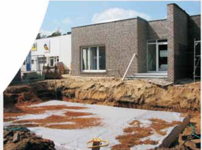
Foto 3. Geotekstiiliga ümbritsetud sademeveemahuti enne tagasitäitmist
