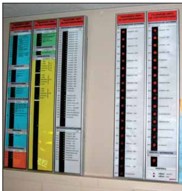
JOONIS 1. LED-INDIKAATORITEGA TABLOO. IGAL SÜSTEEMIL ON OMA TAUSTAVÄRV
