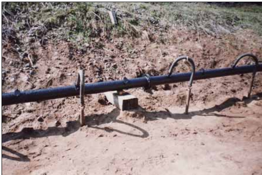
SAASTUNUD PINNASE TERVENDAMINE KOHAPEAL (KEILA-JOA RAKETIBAASI RAKETIKÜTUSE JÄÄKREOSTUSE LIKVIDEERIMINE PINNASEGAASIDE VÄLJAIMEMISE TEEL)
