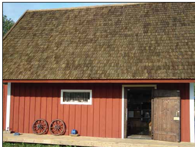
TÕRVALAADSE PUIDUKAITSEVAHENDIGA IMMUTATUD KATUS
