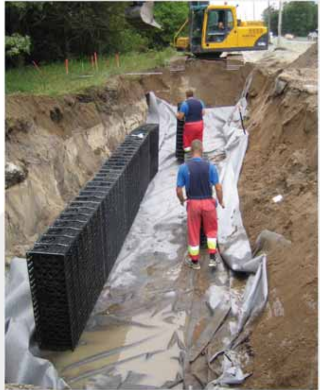
Foto 3. HeitkerBloc -moodulite paigaldamine Merivälja tee rekonstrueerimisel
