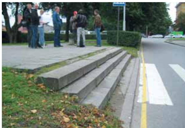
Eluohtlik trepp tuleb haljasala suunas sõiduteest eemale nihutada, kaevisesse süvistada ning käsipuude ja kaldteega varustada
