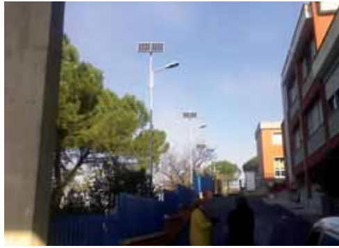
Päikesepaneelidega integreeritud 75W LED-tänavavalgustid Roomas
