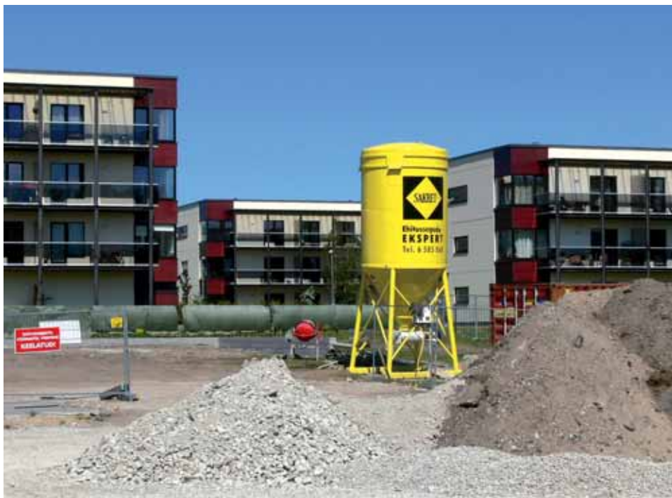
Sakreti kuivsegusilo ehitusplatsil
