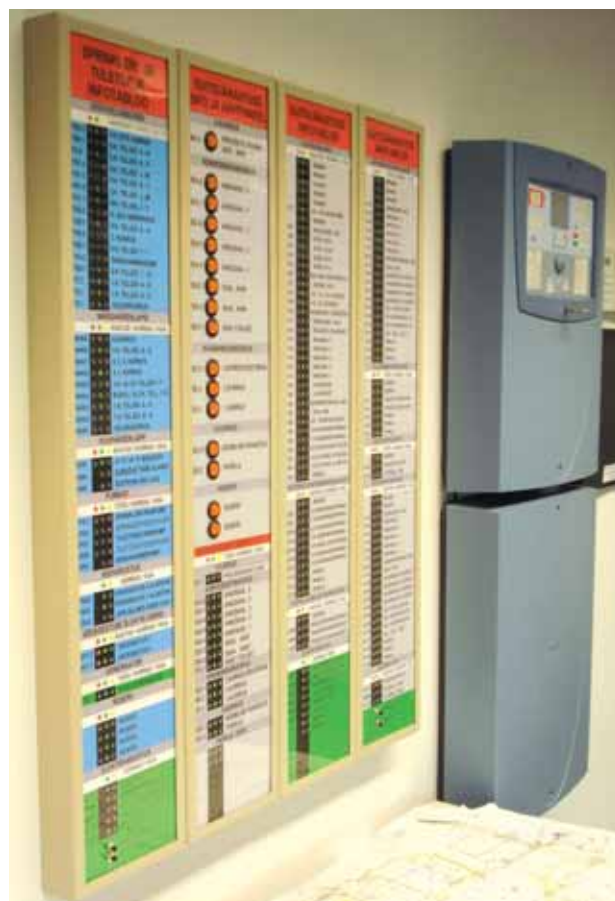
AS Hiiko valmistatud SPR tabloom, SÄ info- ja juhtimistabloom Tasku turvaruumis. Pildil on ka ATS (paremal)
