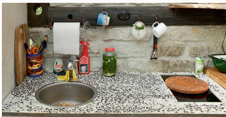
Töötasapind, milles on kokku segatud valge betoon ja graniitkillustik, on peremehe kädetöö. Selle siidine ja kivisäbruline pind on saavutatud lihvimisega.
