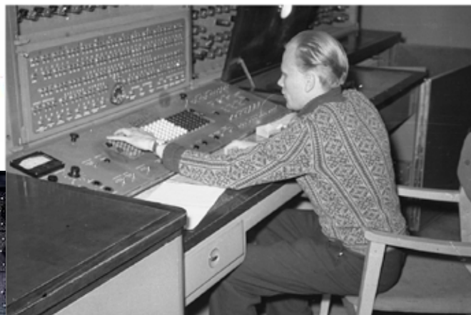
Elektronlampide plaadid. Plaadid lampidega arvutis. Mati Krull Eesti esimese arvuti Ural-1 juhtpuldil.
