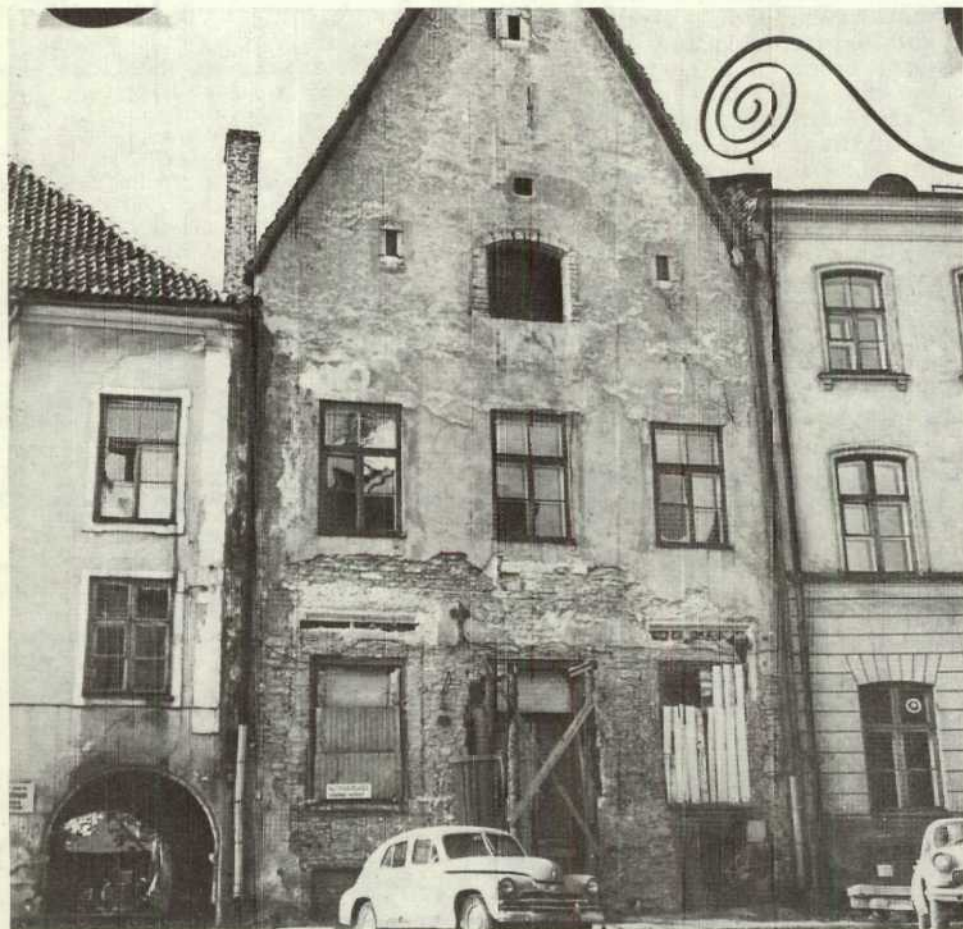
Laia tänav 23. praegune Noorsooteatri väike maja, 1966. aastal. Aknal silt: «Noorsooteater. Sissekäik hoovist».
