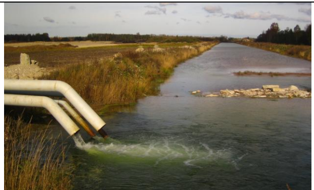
Joonis 91 Pärast kaevandusvee settimist settebasseinist juhitakse Ubja põlevkivikarjääri kaevandusvesi Toolse jõkke
