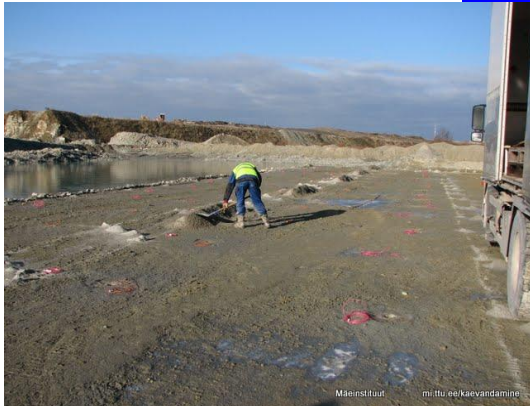
Joonis 40 Lõhkevõrgu monteerimine
