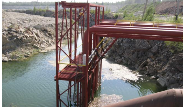
Joonis 93 Pumbajaamast suunatakse Aru-Lõuna lubjakivikarjääri kaevandusvesi Toolse jõkke
