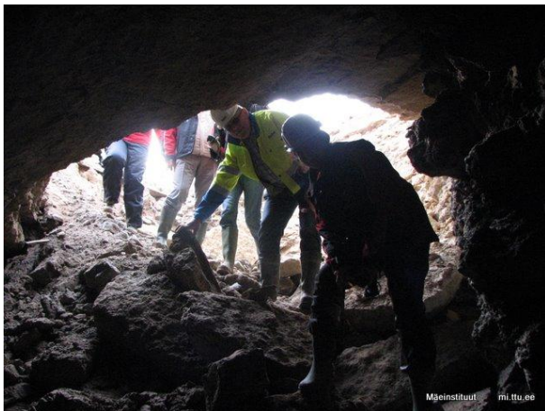
Joonis 69 Varing Kukruse kaevanduses Jõhvi-Kukruse maanteel
