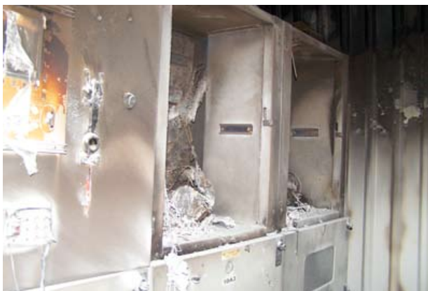
Joonis 96. Tapa alajaama 10 kV jaotlas toimunud põlengu tagajärjed
