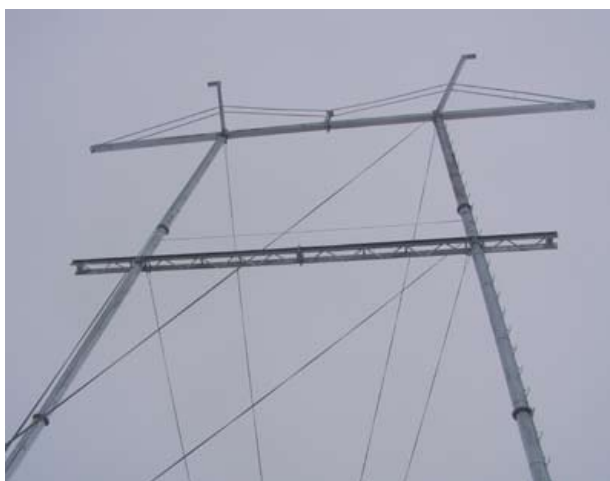
Joonis 81. Tartu – Viljandi – Sindi 330/110 kV õhuliini uut tüüpi mastid
