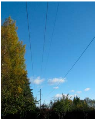
Joonis 95. Näide 110 kV õhuliinile kitsaks jäänud trassikoridorist
