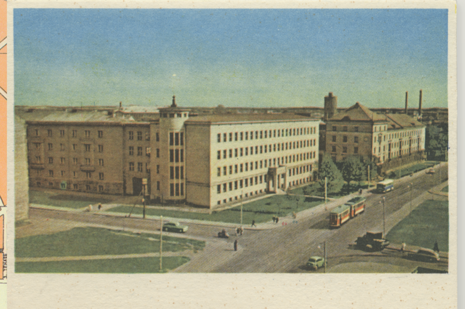
Vaade Tõnismäelt Pärnu mnt. suunas Vista dal Tõnismägi con affaccio sulla strada Pärnu View from Tõnismägi facing Pärnu Road
