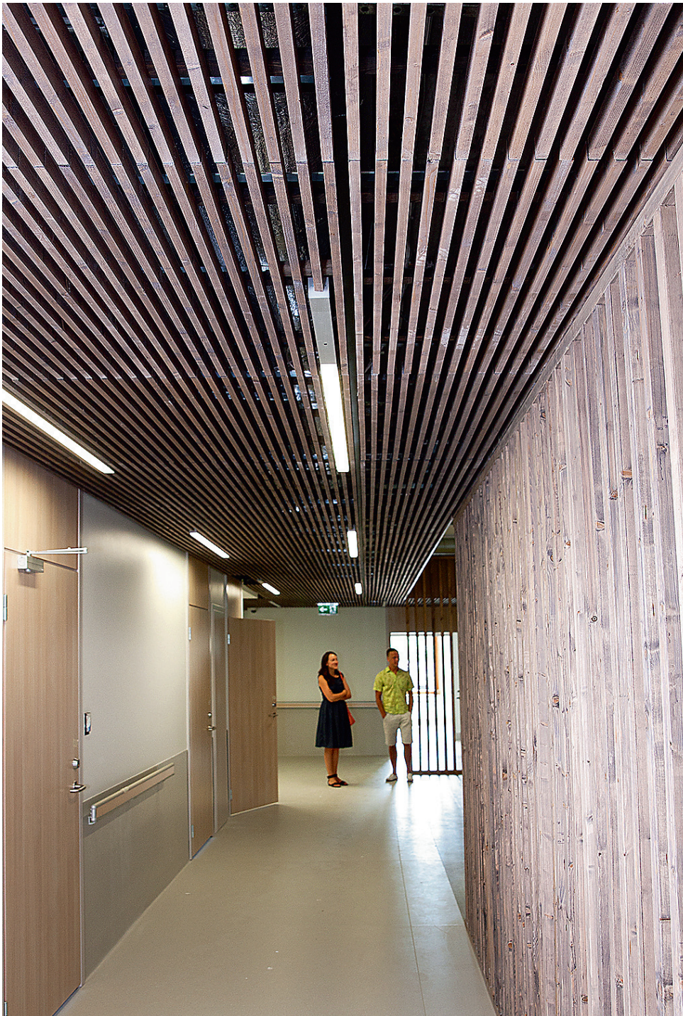
RAKVERE haigla laes kasutati väheste oksakohtadega kuusepuitu, mis viimistleti tuletõkkepeitsiga MP-FR.
