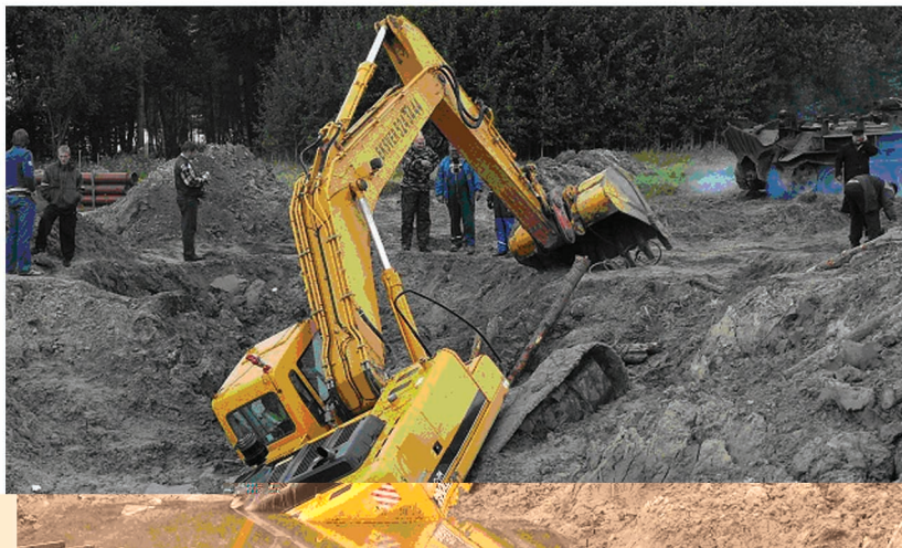
Foto 1. Kaevdõnde varisenud ekskavaator (pärast varisemist pööras operaator ekskavaatori torni 180°, misjärel masin vajus sügavamale savisse).
