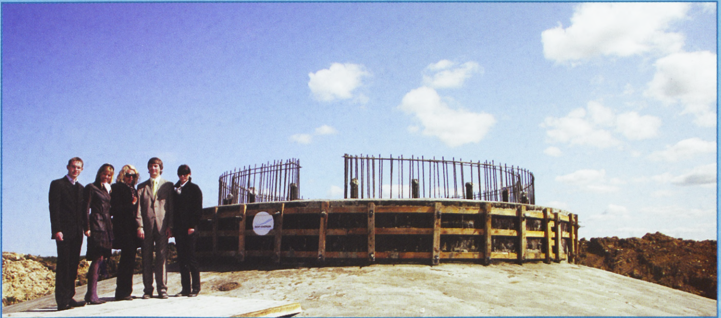
Rain Aulepa tuulepargi nurgakivi panekul.
