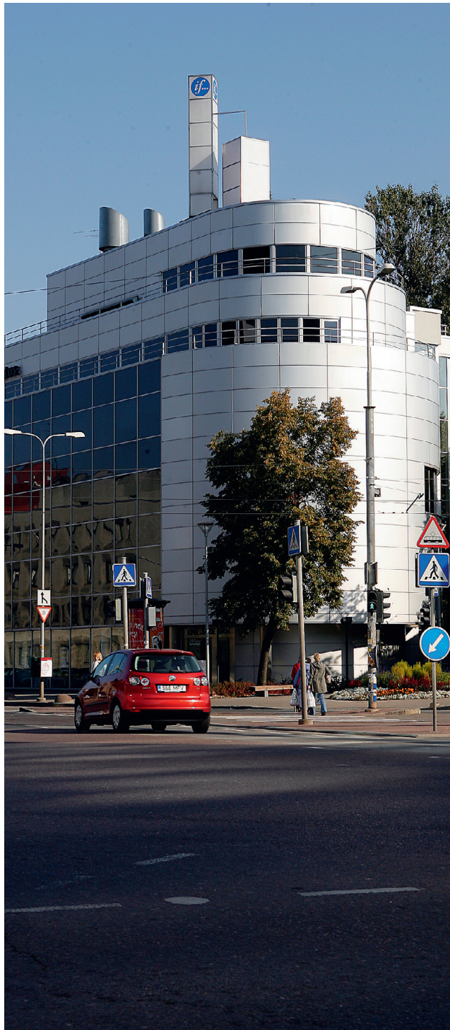
► If Eesti Kindlustuse hoone roosteavad plekid toodi Taanist, et sile pind oleks mõlkideta.
