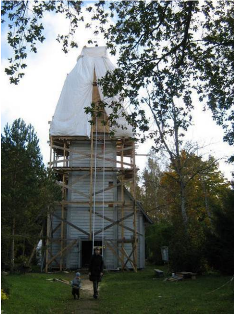
Nõva kiriku tornitööd, 02.10.2012 Foto: Kalli Pets
