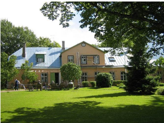
Räägu mõisa peahoone fassaaditööd, 01.08.2012 Foto: Kalli Pets
