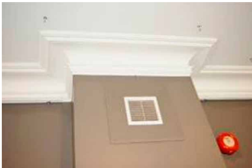
Joonis 2. Stukk I korruse saalis.
