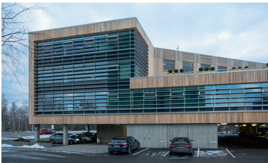
Büroohoone akende ees on horisontaalsed ribad ja sirmid, mis püüavad kinni üleilgse päikese.
