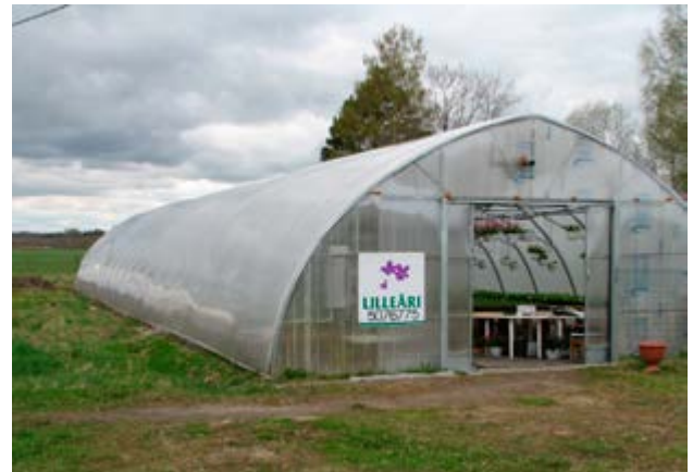
Foto: tunnel 8 m Gothic
