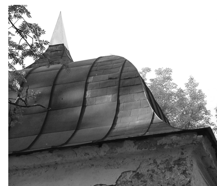
Purdi mõisa kabeli raudplekist katus 19. saj. (Foto: Ü. Puustak)
