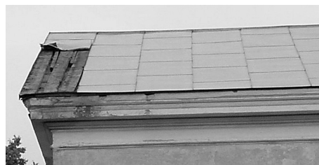
Halvasti kinnitatud plekk. (Foto: J. Vali)
