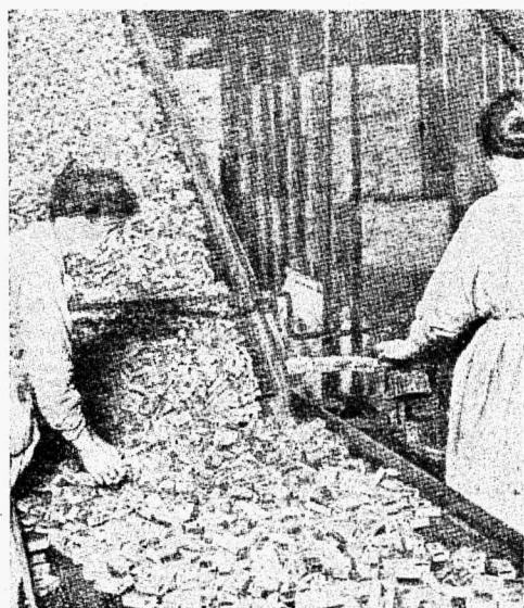
13. Masina teisest otsast tulevad välja juba valmis tikukarbid, ja viiakse kuivatusruumi.
