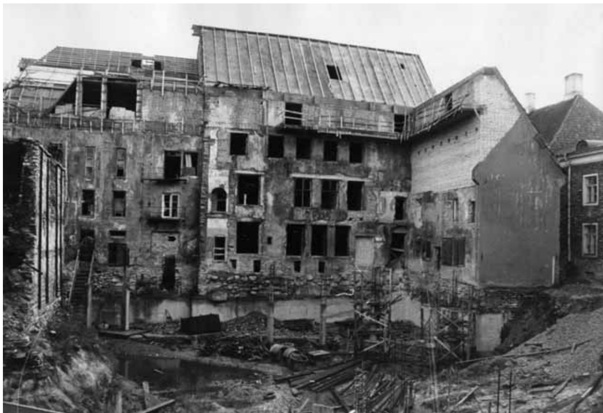
Hoonete Lai 19 / Aida 2 ja Lai 21 hoovipoolsed fassaadid aastal 1990.
