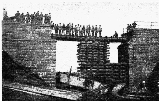
Vaenlase poolt purustatud raudteesilla parandamine ajutiseks liiklemiseks meie vägede poolt.
