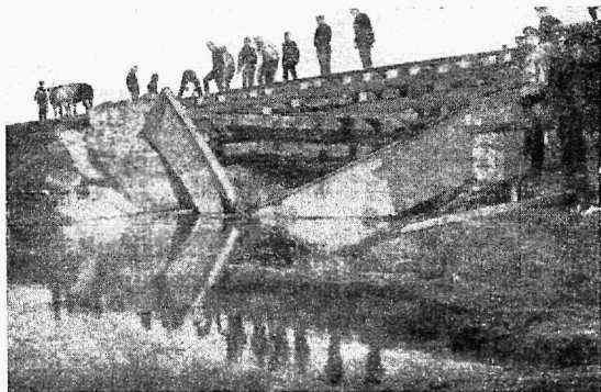
Meie remonstrongi poolt liiklemiseks kordasetatud punavāgede poolt purustatud raudteesild suvel 1919. a.
