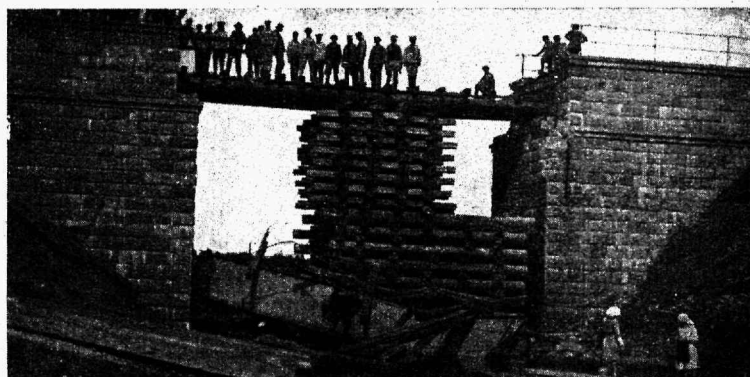
Enamlaste poolt purustatud Polkovo raudteesilla (Pihkva juures) ajutiseks liiklemiseks kordaseadmise Soomusrongide Diviisi poolt mai lõpul 1919. a.
