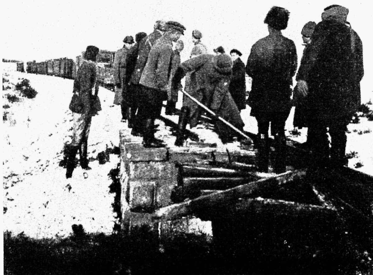
Kitsarööpmeline Soomusrong Nr. 2 Vabadussõjas vaenlase poolt purustatud Kaagvere raudteesilda ajutiseks liiklemiseks korda seadmas.
