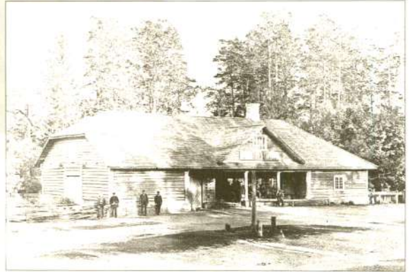
Pruulide Aaviku talu Metsiku külas
