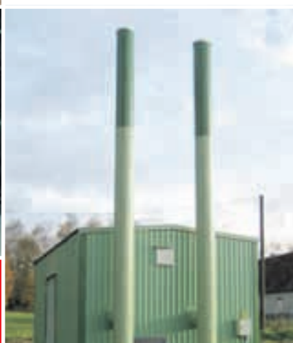
Lähte aleviku 1,2-MW täisautomaatne gaasikonteinerkatlamaja
