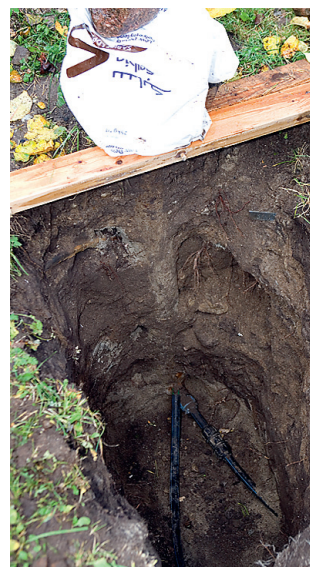
▶ Lohakalt tehtud kaevutööd on keerukas ja kulukas paranda. Selle suurkaevu pidi uuesti lahti kaevama et sättida paika vildakalt paigaldatud pump ja lisada rauafilter.
