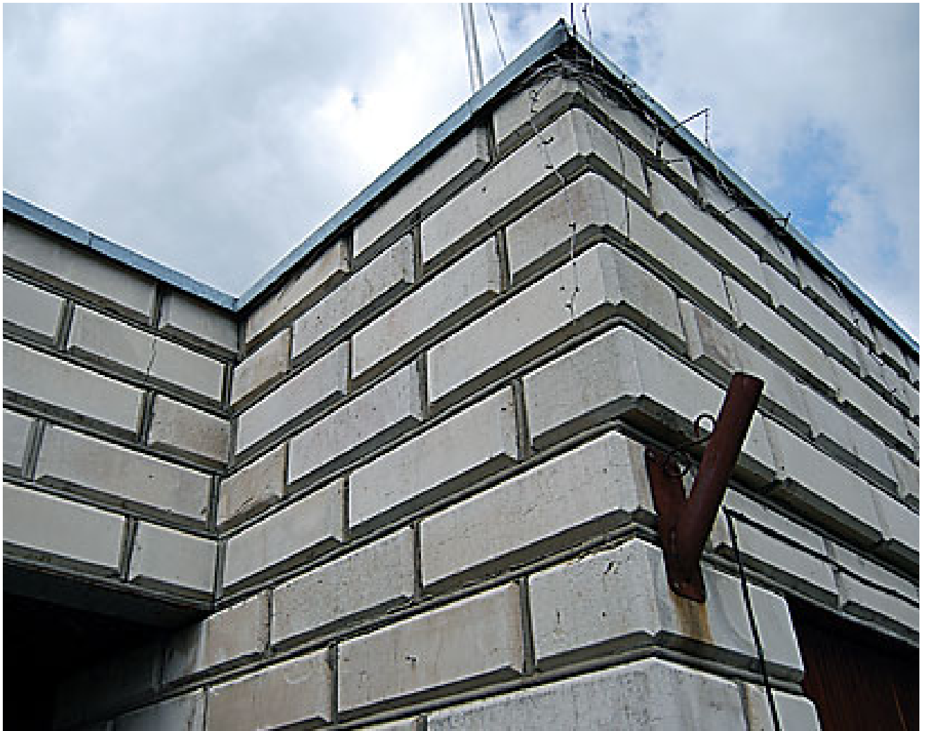
► Nõukaaegne püüd teistest erineda ehk majaehitaja nutikus – võttis vaevaks kandilistel nn Narva plokkidel välimised servad kalde alla freesida ja siis puhta vuugiga seina laduda.
