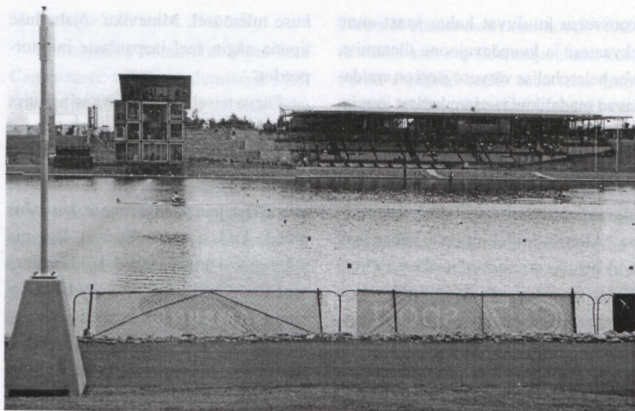
Sydney olümpiamängude sõuderegati võistlusrada avati 23. septembril 1999. aastal Kagu-Aasia ja Okeaania sõudjate võistlusega. Finišiliini teevad nähtavaks veepinna alla paigaldatud surveõhutorust tõusvad mullikesed. Sõudekanali vastaskaldal asub finišijoonel kohtunike torn, sellest paremal pealtvaatajate tribüün.
