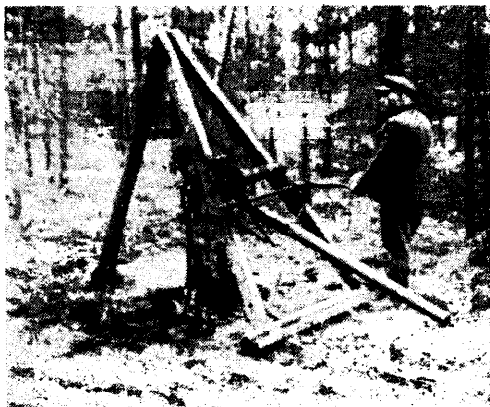
Joon. 2. G. Tuviku konstrueeritud vähema- jõuline kannutõstja Sõmerpalu meeskonnas Foto K. Sotter 1940
