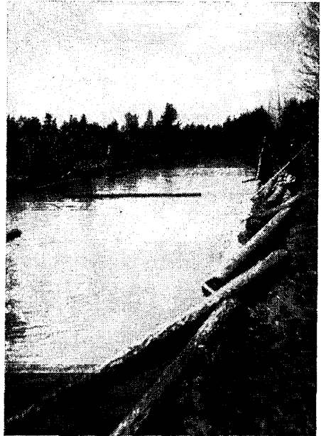
Joon. 2. Dobrina kanalil on madalatele kallastele palkide kinnijäämise vältimiseks juhtpalke otsapidi kaldale tõmmatud (kanal voolab vaataja poole!). Liinitööl on ka naisi.
