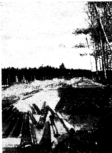
Joon. 1. Palkide parvetamine 1939. a. õgven-datud ja süvendatud Konsu jõel. A — parvetatava materjali end. jõesängi mineku takistamiseks ja siit parvetajate ülepääsmiseks on tõmmatud palk.
