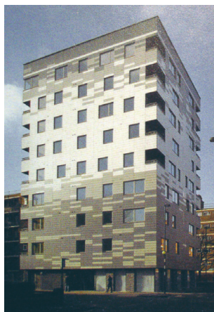
► Arhitekt: primus arhitekter, 2009.
