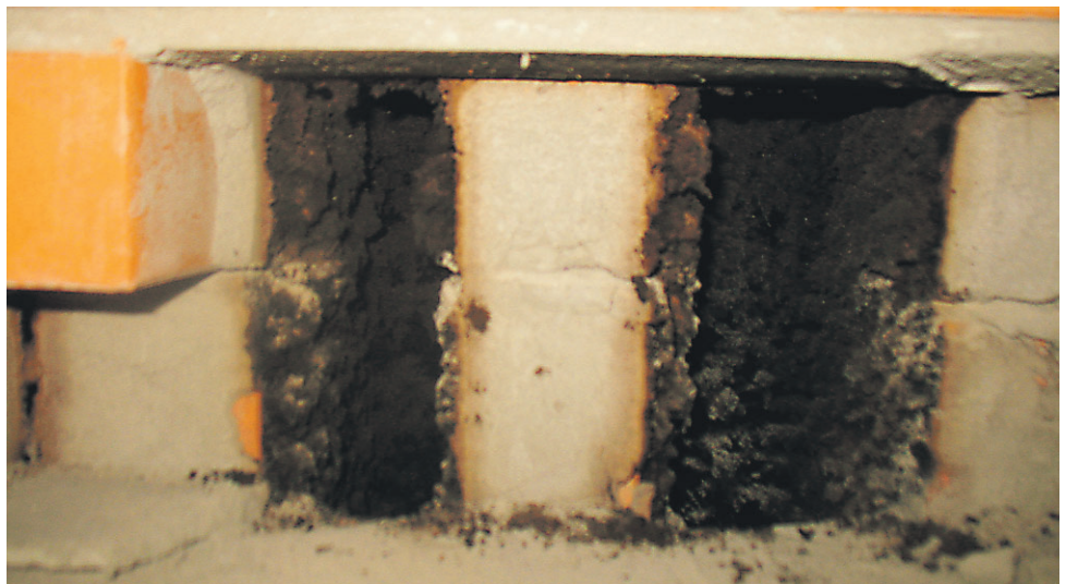
► Vaid aasta tagasi valminud soemüüri avades selgus, et lõõrid olid ehitatud liiga kitsad. Selgesti on näha tahmakihi paksus lõõri seintel.
