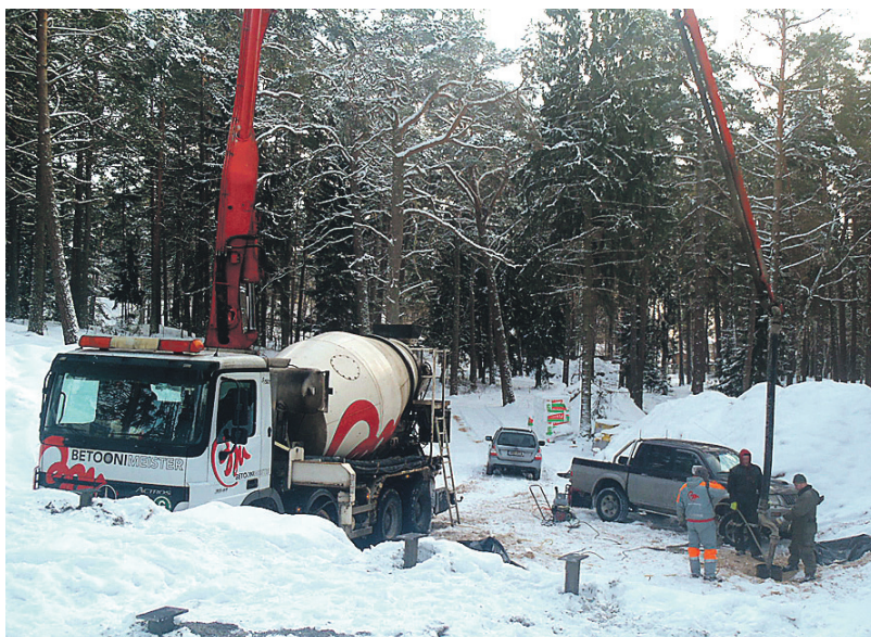
BETONITÖÖD õnnestusid kärelda külma kiuste. FOTO: TIMBECO EHITUS
