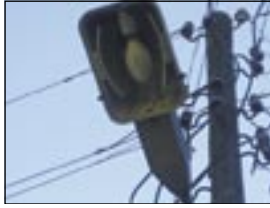
Foto 9. 400 W elavhõbedapirniga valgusti ja paljasjuhtmetega õhuliin.
