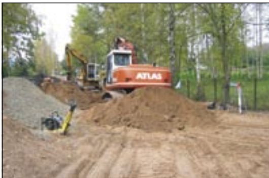
Foto 6. Vee- ja kanalisatsioonitorustiku ehitamine Metshaldja tänaval, 2003.
