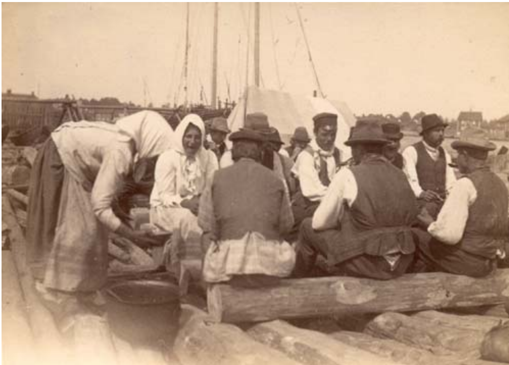
19. Töölised Emajõe kaldal lõunatamas. Foto: K.E.Sööt B-31:52
