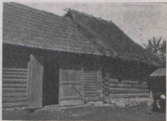
Pilt 33. KONDRA TALU REHETUBA ja rehealune väljastpoolt. Obinitsa kl. Paremas ääres näha väravakatuse ots. Rehetoa hoovipool- ses seinas väike aken ja paja.
