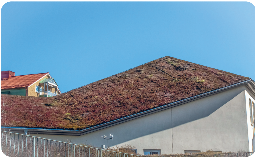
Ekstensiivset rohekatusust saab rajada ka kaldpinnale. Malmö, Rootsi. Foto: Jolanda Lipu.
