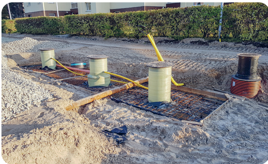
Õli- ja liivapüüduuri paigaldus. Haabneeme, Viimsi. Foto Alar Mik.
