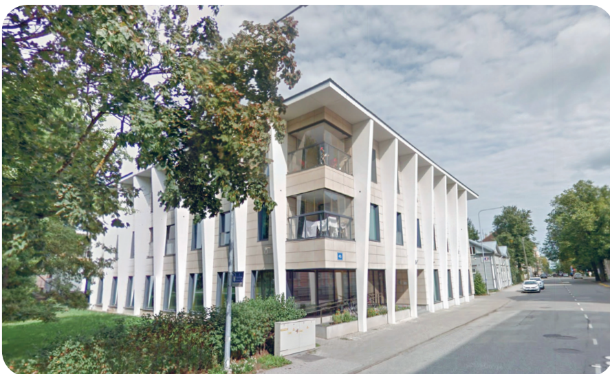
Sademevee kogumis- ja kasutamissüsteem Tartus, Vanemuise 45. Sambad varjavad vihmaveetorusid, mida mööda katuselt kogutud sademevesi voolab maja alla peidetud 13 kuupmeetri suurusesse kogumispaaki. Kogutud sademevett kasutatakse maja WC-pottides ja pesumasinate. Foto: Google Maps street view.
