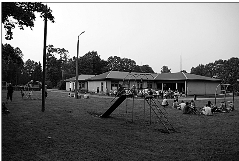
• Kamara külakeskuse hoone sai sel suvel uue plekk-katuse. MEELIS SÕERDI foto
