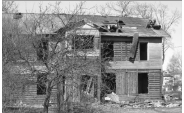
Raudteeülesõidu kõrval käivad sel kevadel aktiivsed lammutustööd.
